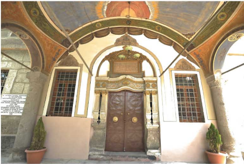
Kilisenin batı cephesinde yer alan yarım kubbeli girişi
